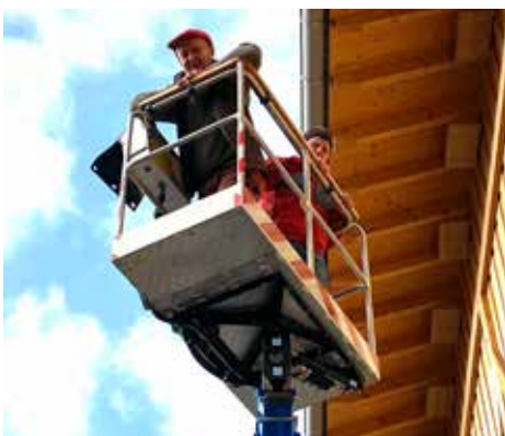
Die Hebebühne macht's möglich.....!
