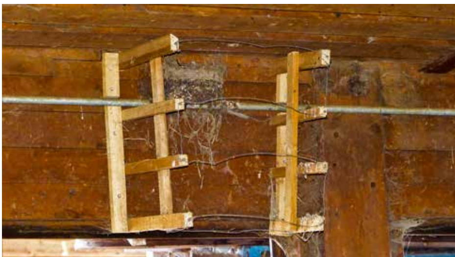
Das neugebautes Holzgestell aus dünnen Latten zur Rettung der Schwalbenbrut im Kuhstall
