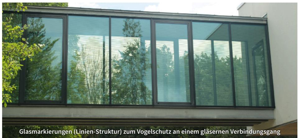
Glasmarkierungen (Linien-Struktur) zum Vogelschutz an einem gläsernen Verbindungsgang
