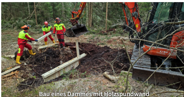
Bau eines Dammes mit Holzspundwand
